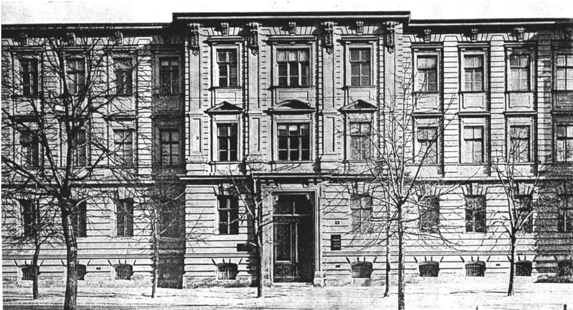
Zgrada Tehniške visoke šole na Rooseveltovom trgu prije nadogradnje
